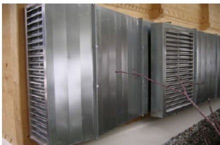
Oben: Umbau EFH Dübendorf: Schallschutz bei beengtem Platz verlangt nach innovativen Lösungen. Unten: Neubau Chalet Rougemont: hangseits installierte, flache Aussenluft-/Fortluftluftkonstruktion.
