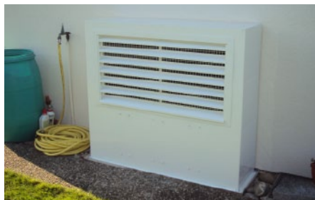
Unten: Gedämmter Lichtschacht – Neubau EFH Herisau – der Einbau der Schalldämmkulissen (vgl. Bild «Schalldämmkulissen») erfolgt anschliessend.
