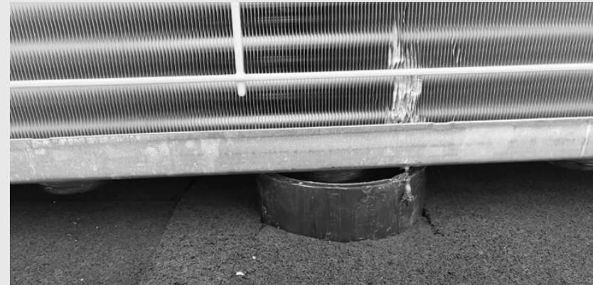
**Bei erhöhtem Vereisungsrisiko (geografische Lage beachten) ist eine Ablaufheizung vorzusehen. Die Verantwortung für die entsprechenden Abklärungen liegt beim Planer/Installateur welcher die Wärmepumpe/das Klimagerät realisiert. Wird eine Ablaufheizung eingesetzt, so muss bei der Bestellung der Schallschutzkabine Silentus ProTECH die TECH AG schriftlich informiert werden.**
